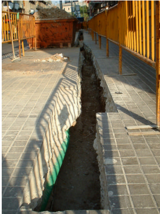
FOTOGRAFIA 1: Vista general de la Rasa 100, en carrer de Pelai, 9-11.
